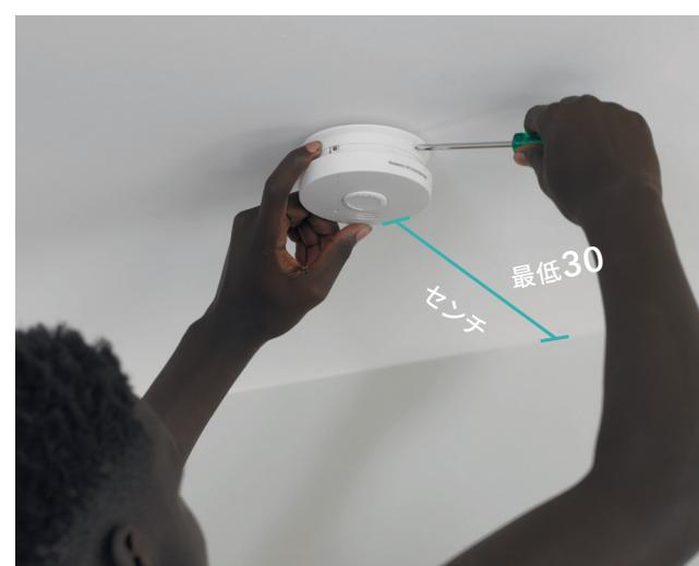
ご家庭の各階の天井に設置し、その際は壁から最低でも30センチの距離をおいて取付けてください。
