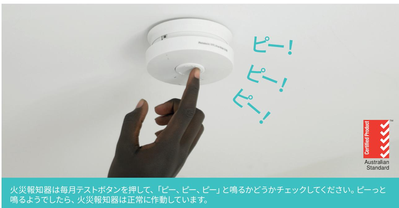
火災報知器は毎月テストボタンを押して、「ピー、ピー、ピー」と鳴るかどうかチェックしてください。ピートと鳴るようでしたら、火災報知器は正常に作動しています。
